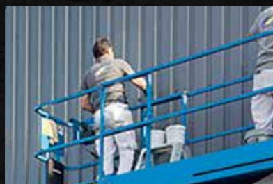
Oprissen en renovatie van metalen gevelbekleding
