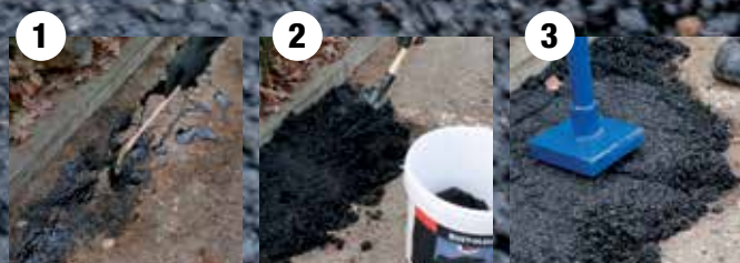
Primer aanbrengen
