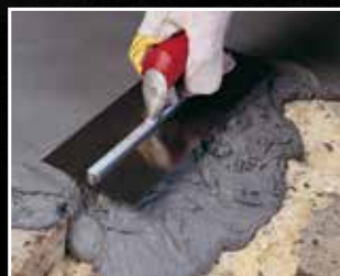
RÉPARATION DU BÉTON
