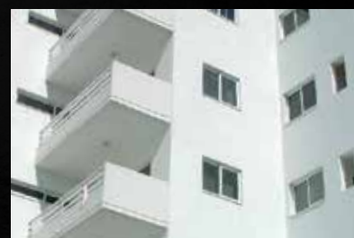
Étanchéité de murs extérieurs
