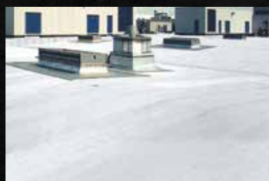
Rénovation d'une toiture complète
