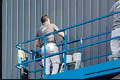
Verjüngung und Renovierung von Metallverkleidungen
